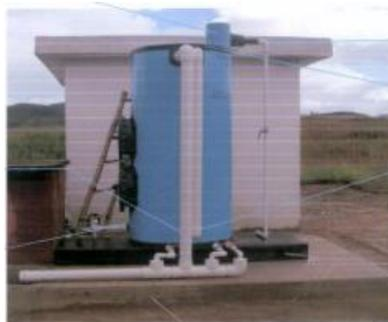
Imagen 6. Sistema de Tratamiento Agua Potable Aeropuerto Ocaña
